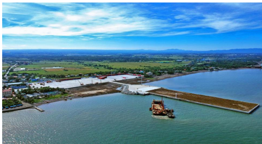
菲律宾甲米地集装箱转运码头升级改造项目（中国港湾承建）
